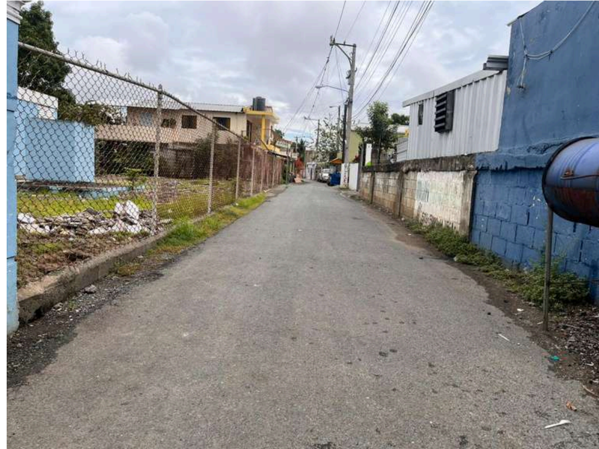
ASFALTO CALLE DE LA POLICLINICA
