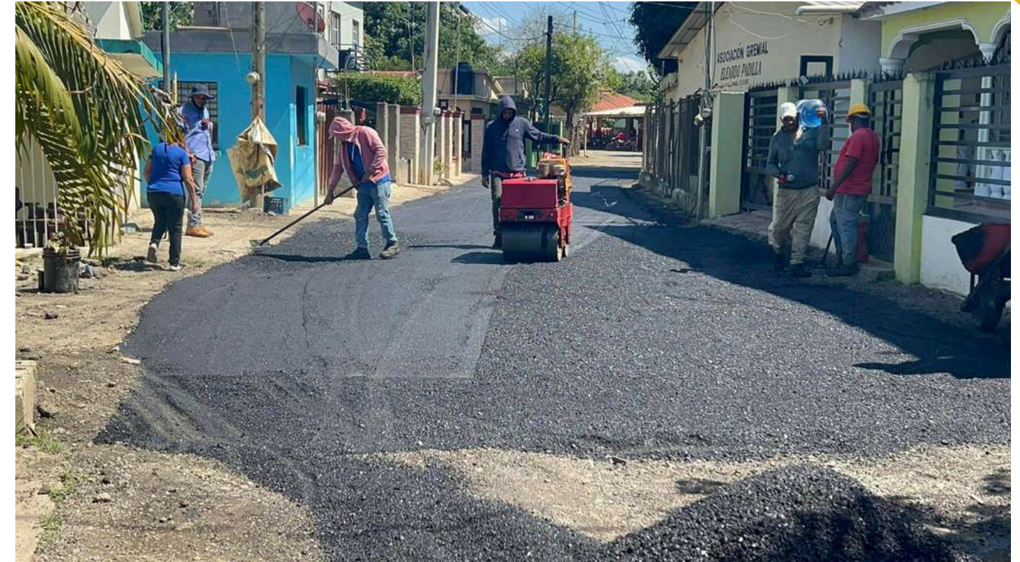
ASFALTO LAS ESCOBAS JIMA ARRIBA
