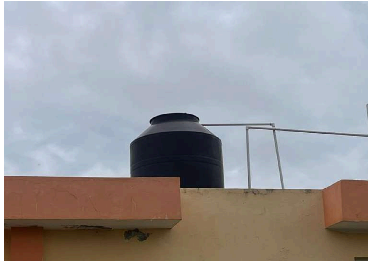
INSTALACION TINACO AL AYUNTAMIENTO
